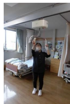
↑（写真4）天井走行式リフト
